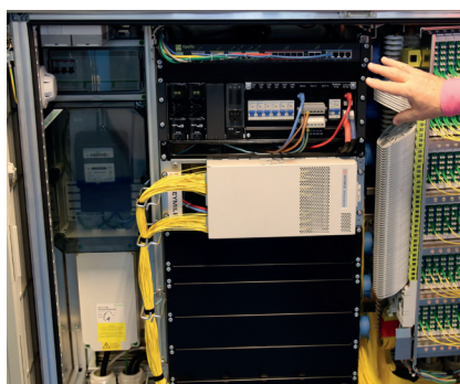
STEROWNIK APOLLO ZOSTAŁ ZAPROJEKTOWANY DO MONTAŻU W SZAFIE 19-CALOWEJ.
